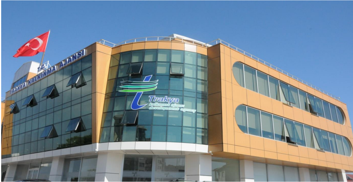
Şekil 1: Trakya Kalkınma Ajansı Hizmet Binası
