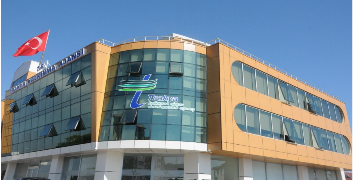
Şekil 1 Trakya Kalkınma Ajansı Hizmet Binası
